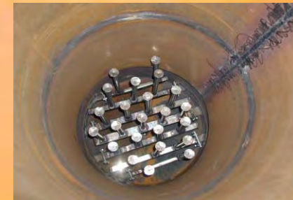
Montaža pećurki za fluidizaciju na distributor vazduha za fluidizaciju
