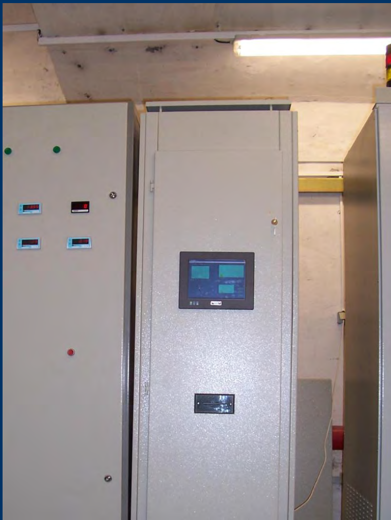
Централна надзорна јединица мерног система са подсистемом за праћење температура са стационарних давача
